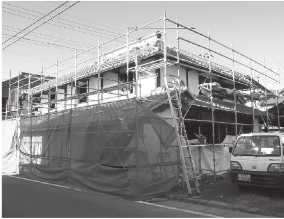
図1 修理事業中の様子（真壁地区）
