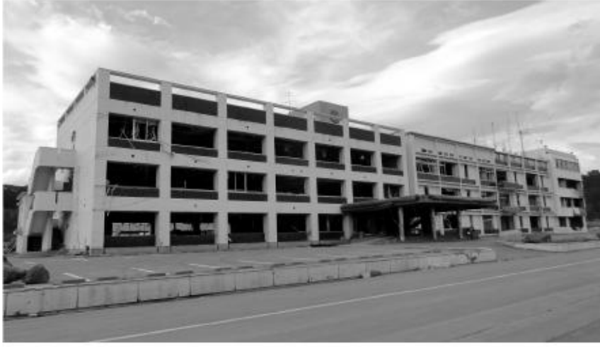
写真3 被災した市庁舎
