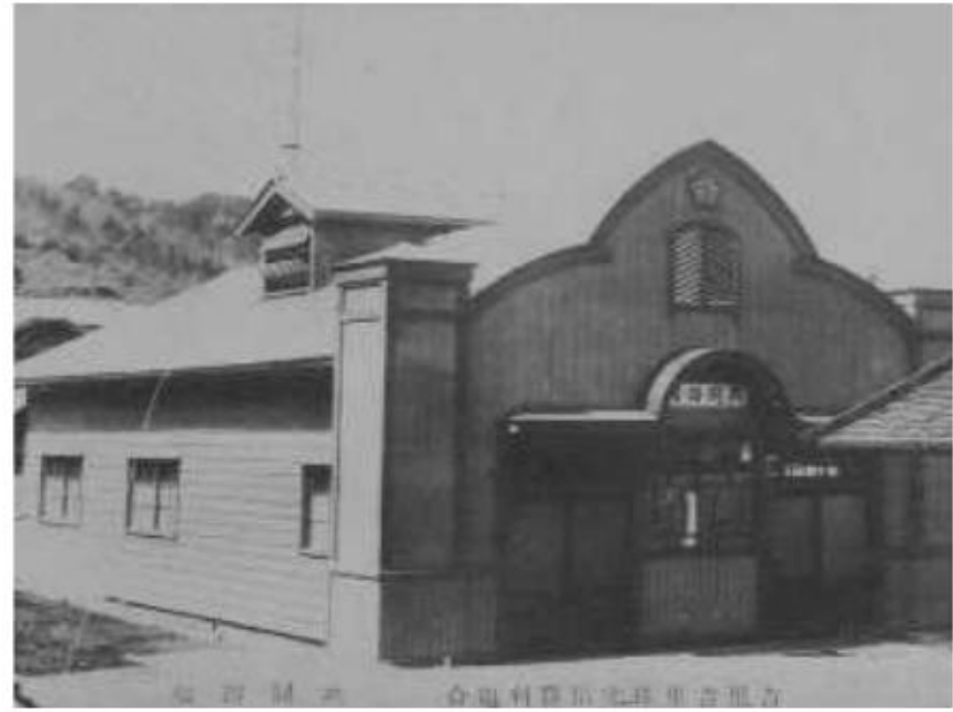
写真2 昭和三陸津波の復興(共同浴場) (写真提供: 藤本俊明)
