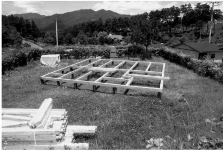
図 8.4 戸建て木造仮設住宅基礎工事
